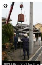
③ 鋼管+ポンプ+コンプレッサー
