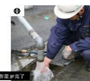
⑪ 洗淨作業が完了
