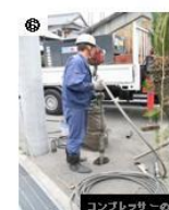
⑥ コンプレッサーのホースを挿入
