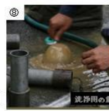
⑧ 洗淨用の鋼管に交換する
