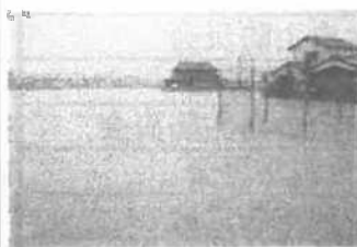
国道鷹丸線より 寿方面(冠水状況)
