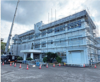
小中学校躯体健全化（玉津小学校）
