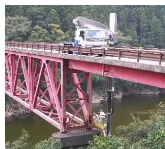
点検車による点検
